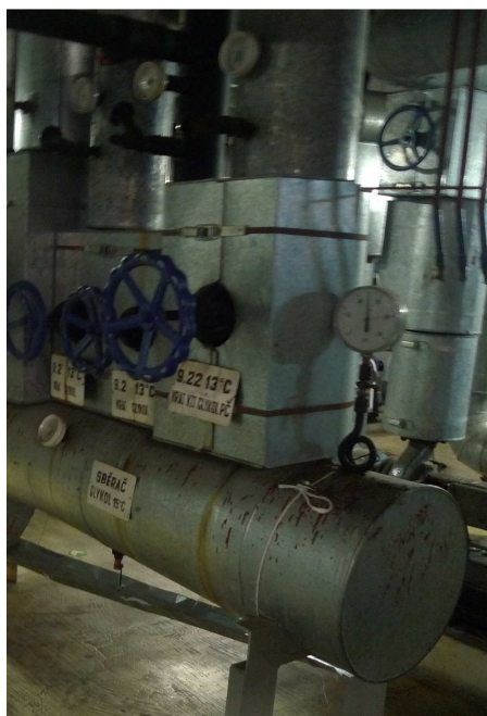
Obrázek 8: Odstavení chladicí větve pro VZT (9.22)
