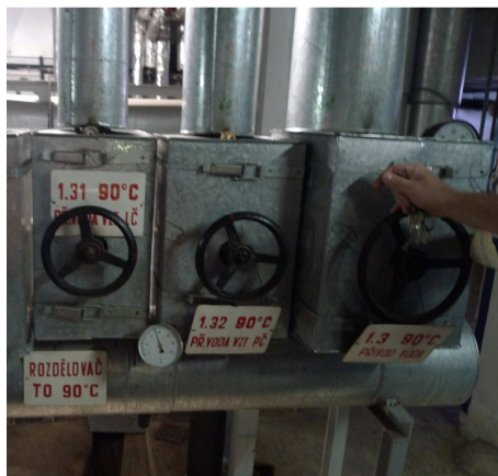
Obrázek 5: Odstavení otopné větve pro VZT – přívod (1.32)
