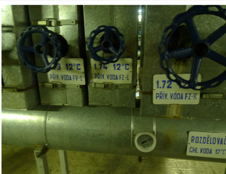
Obrázek 3: Odstavení chladicí větve pro RADIERY – přívod (1.74)
