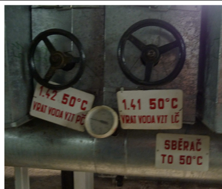
Obrázek 6: Odstavení otopné větve pro VZT – vrat (1.42)
