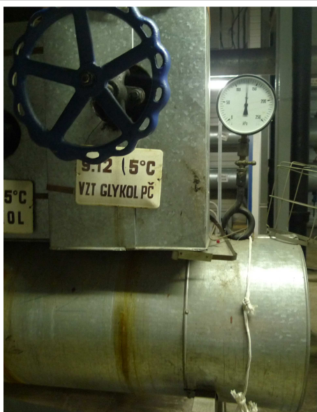
Obrázek 7: Odstavení chladicí větve pro VZT – přívod (9.12)
